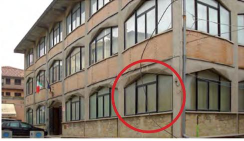
murario alto circa 1.20 m realizzato con muratura a cassetta esternamente a faccia vista, sormontato da infissi sagomati come le travi perimetrali. L'unica differenza si ha al piano seminterrato del corpo A, dove la tamponatura è costituita da un paramento in mattoni pieni e pietra dello spessore di 40 cm. Le ampie vetrate presenti su quasi tutte le specchiature rendono minima l'interferenza dei tamponamenti con la struttura.
